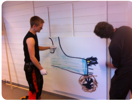
Barnehager bygget før 2005 har ofte dårligere lydforhold enn nyere barnehager. Men også nyere barnehager og rehabiliterte barnehager kan ha dårlig akustikk/lydforhold. Her er montører i aksjon på Molkeholen Barnehage i Stavanger.
